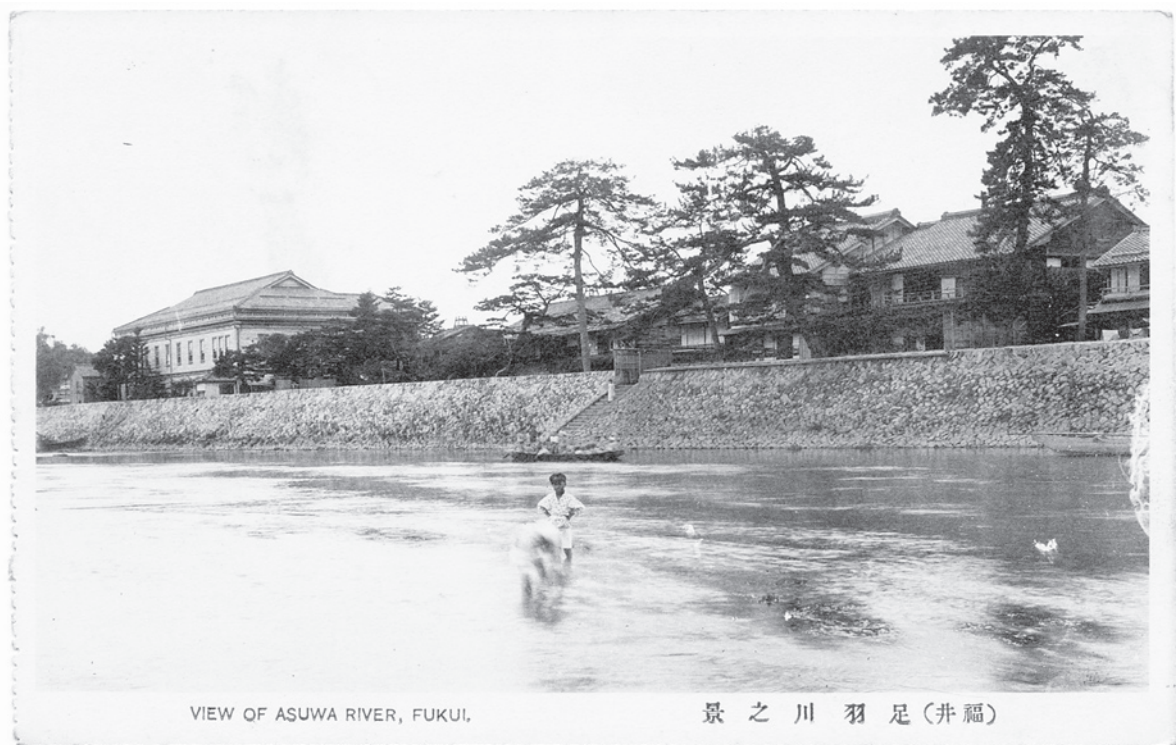
写真1 足羽川の絵葉書（上 明治中期改修工事前 下 同後期改修後）
